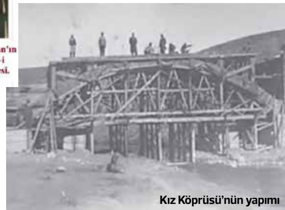
Kız Köprüsü'nün yapımı
